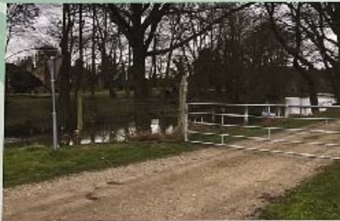
A63 doorgang creëren langs kasteel ruïne vanaf Bleijenbeek
